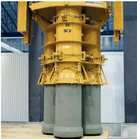
Bild 3.9: Ziehen der Außenschalung
