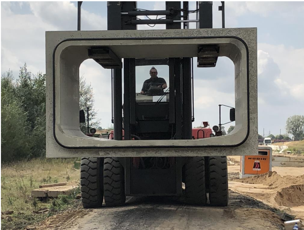
Das 22,8 Tonnen schwere Rahmenprofil wird zur Baugrube gefahren, Foto: Bettina Friedrichs
