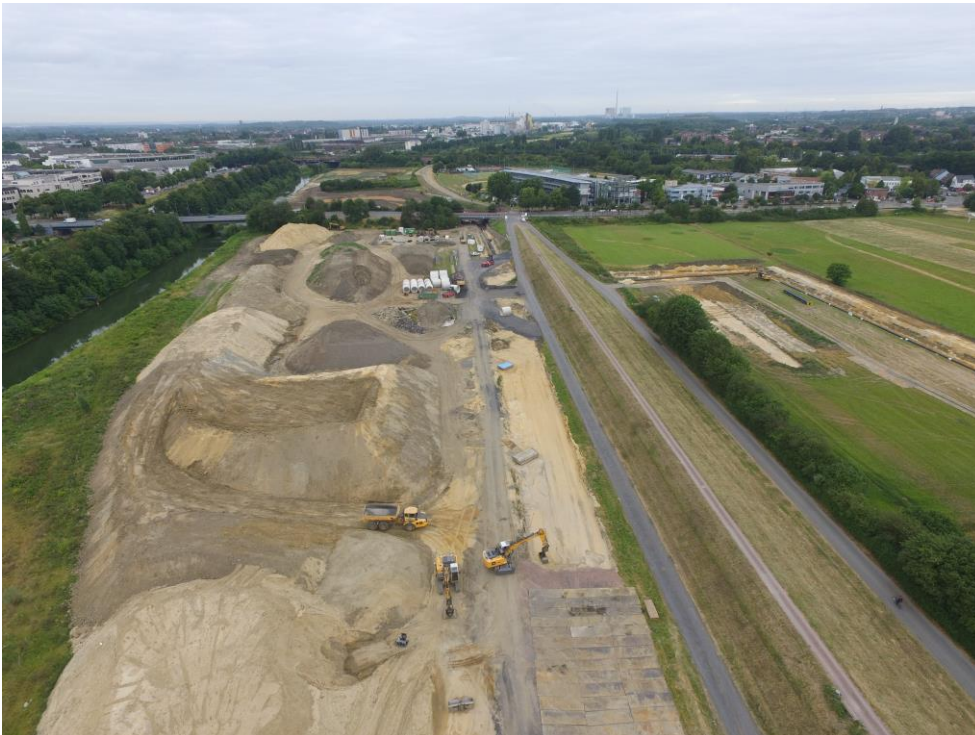
Blick von oben auf die Baustelle, Foto: Klaus Stewering GmbH & Co. KG
