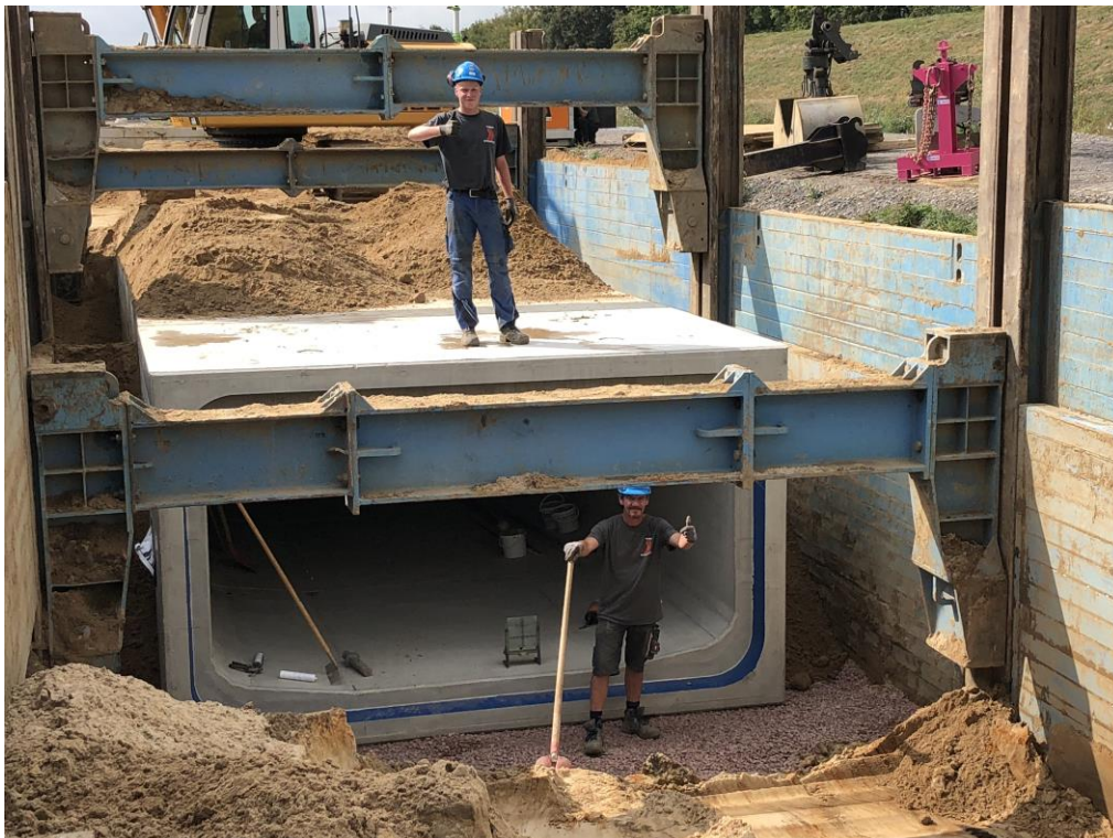
Das Stahlbetonrechtprofil wird fachgerecht verlegt, Foto: Klaus Stewering GmbH & Co. KG
