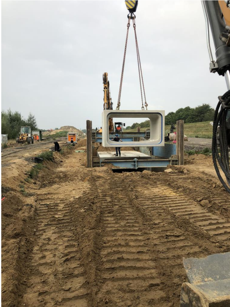
Das Stahlbetonrechtprofil wird fachgerecht verlegt, Foto: Klaus Stewering GmbH & Co. KG
