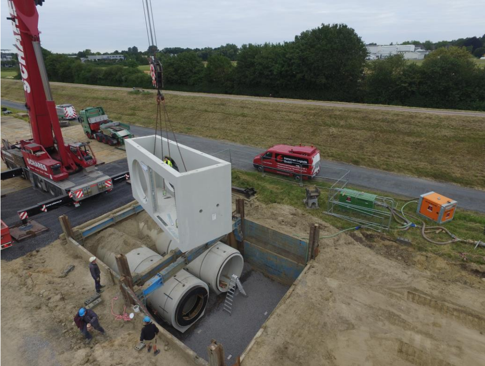
Das Auslaufbauwerk wird eingebaut, Foto: Klaus Stewering GmbH & Co. KG
