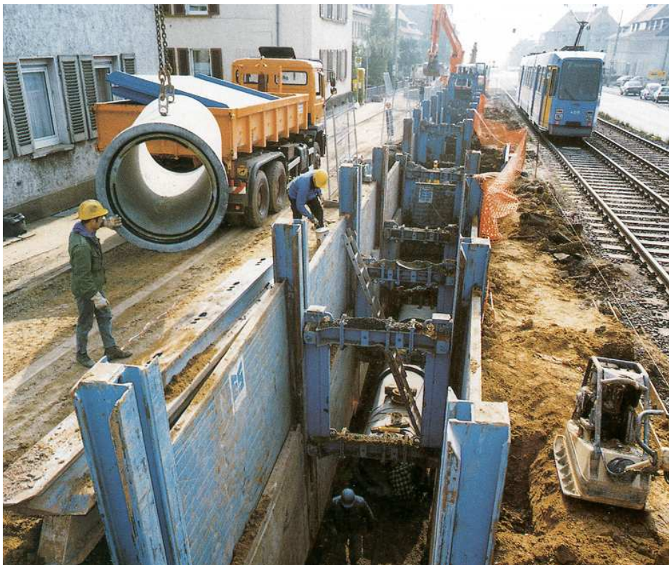
Bild 1 Verlegung von Betonrohren in offener Bauweise mit Hilfe von Verbaugeräten zur Sicherung der Grabenwände [3]
