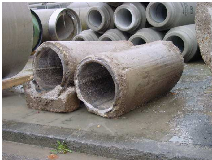
a) 120 Jahre alte Betonrohre mit Kreisquerschnitt, gefunden in Bonn
